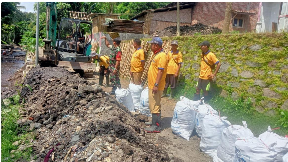
Saat ini dilakukan disekitar lokasi sungai yang bertepatan di Dusun Oloh Desa Ajung RT 02 RW 10 sepanjang sekitar 500 meter lagi dengan lebar 5 meter dan kedalaman sekitar 30 Cm, dengan pemantauan dilakukan oleh Kupa Sumberdaya Air (SDA) UPT Kalisat, Babinsa dan warga.
